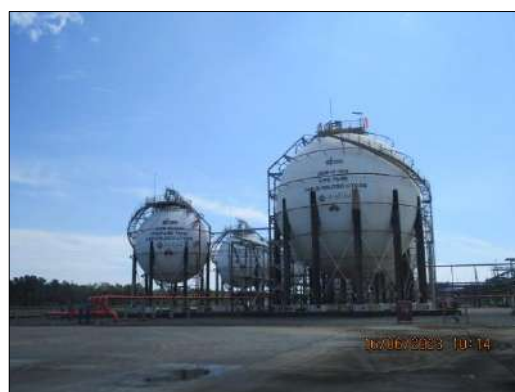
รูปที่ 2-63 พื้นที่จัดเก็บสำหรับ NGL tanks, Hot oil tank, Diesel storage tank ที่มีคันล้อมรอบเพื่อป้องกันการหกรั่วไหล
