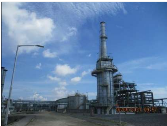
รูปที่ 2-7 Hot oil Heater
