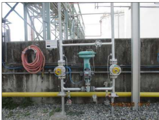
รูปที่ 2-61 วาล์วปิดกั้นระบบ (Shutdown valve) บริเวณ พื้นที่ลานถังเก็บสำรองผลิตภัณฑ์เพื่อตัดแยกระบบต่างๆ ออกจากกันเป็นส่วนๆ
