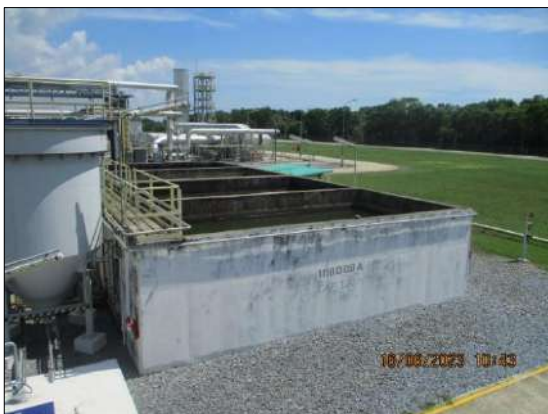
รูปที่ 2-15 บ่อตรวจสอบคุณภาพน้ำ จำนวน 4 บ่อ ขนาดความจุบ่อละ 120 ลูกบาศก์เมตร
