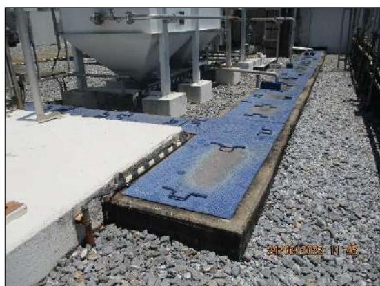
Recovered oil sump สำหรับเก็บรวบรวมน้ำมันที่แยกออกมาจาก CPI และ Flotation unit
