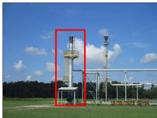
ระบบ Low pressure flare (LP Flare)
