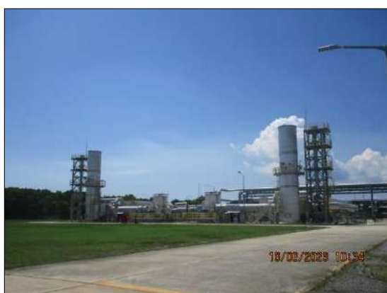
รูปที่ 2-4 ปล่อง Thermal Oxidizer
