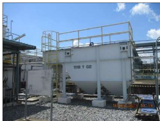
รูปที่ 2-18 หน่วย Flotation unit เพื่อให้น้ำมันที่เหลืออกตัวออกจากน้ำ
