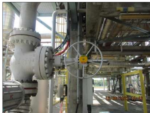
รูปที่ 2-60 ติดตั้งสัญญาณเตือน และมีสัญญาณเตือน Interlock เพื่อสั่งการให้วาล์วตัดแยกระบบปิดตัว
