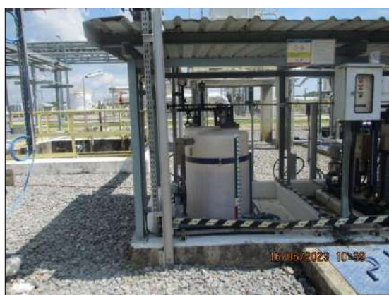
รูปที่ 2-23 การเติมสารเคมี Demulsifier ก่อนเข้าสู่ CPI เพื่อเพิ่มประสิทธิภาพในการแยกตัวของน้ำมัน หรือของแข็งออกจากน้ำเสีย
