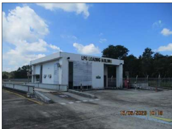
รูปที่ 2-40 ที่ชั่งน้ำหนักรถบรรทุก NGL โดยกำหนดไว้ไม่เกิน 15 ตัน/คัน
