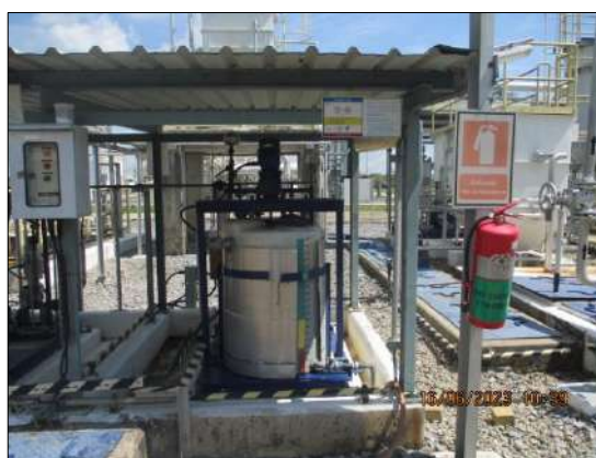
รูปที่ 2-24 การเติมสารเคมี Flotation agent เพื่อเพิ่มประสิทธิภาพในการแยกน้ำมันที่เหลือนอกจากน้ำ
