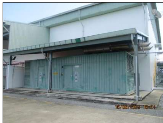
รูปที่ 2-62 เครื่องยนต์ดีเซลที่ใช้ขับเคลื่อนเครื่องกำเนิดไฟฟ้าที่มี การติดตั้งแผ่นปิดล้อมกันเสียง และระบบ Exhaust silencers
