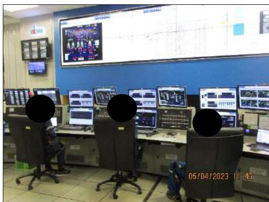
รูปที่ 2-58 การควบคุมและตรวจสอบระบบท่อส่งก๊าซโดยผ่านระบบ SCADA
