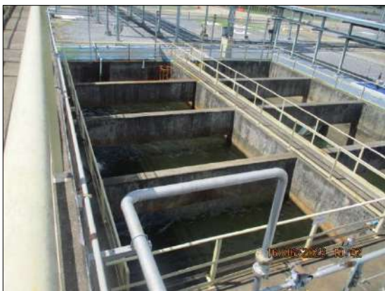
รูปที่ 2-26 บ่อรับน้ำเสียที่มีการปนเปื้อน (Contaminated Water Receiving Sump)
