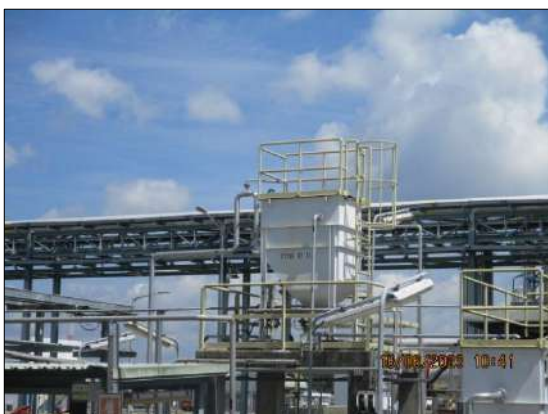
รูปที่ 2-17 แผ่นดักไขมัน (Corrugated plate interceptor : CPI)
