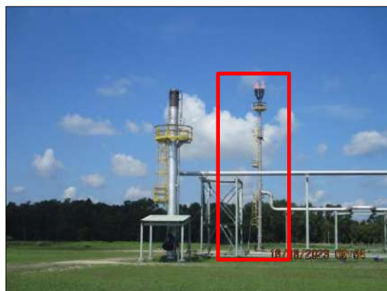
ระบบ High pressure flare (HP Flare)
